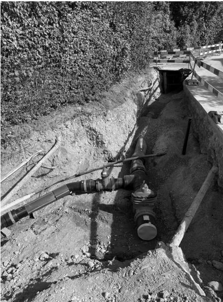
Abbildung 1: Öffnung der Strasse oberhalb der Kurve, um Stromleitungsrohre einlegen zu können.
