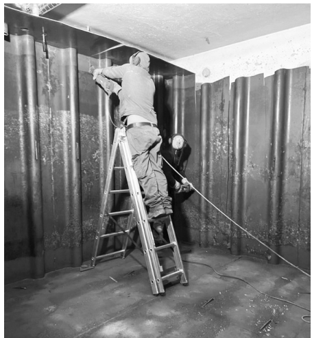
Die Entfernung des alten Öltanks ist eine lärmige Angelegenheit
